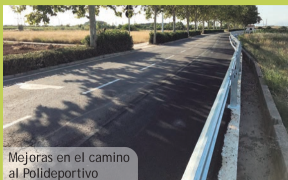
Nuevo carril bici camino de la Pedrera
