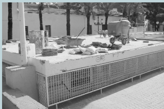
Aspecte de les obres
