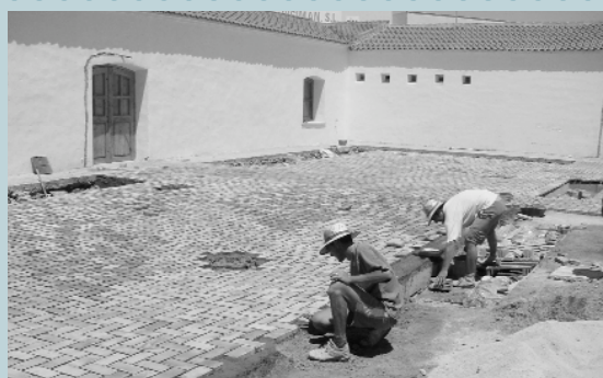
Aspecte de les obres
