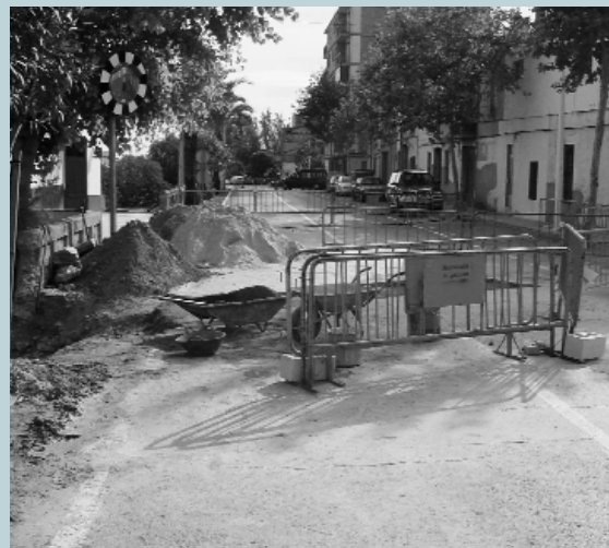
Obres al carrer Ricardo Capella
