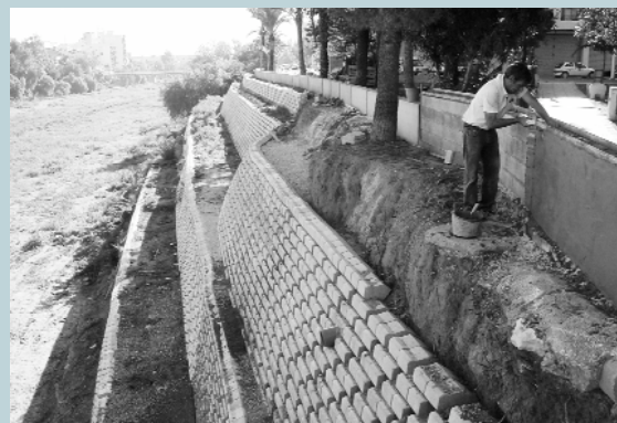
Treballs de millora del mur de contenció
