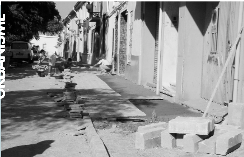
Un moment de les obres
