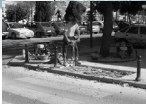
Construcció de rampes a les voreres per a facilitar el desplaçaments de cadires de rodes, carrets de xiquets, etc.
