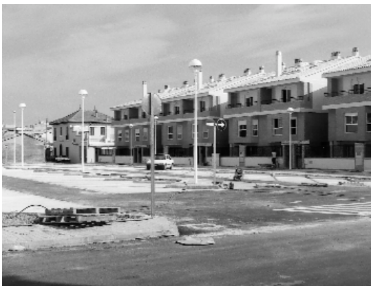
La nova zona d'estacionament pràcticament finalitzada
