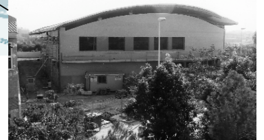
Última fase de les obres de construcció del Pavelló Poliesportiu
