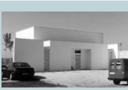
Sala d'assajos junt a l'aparcament del carrer la Taronja
