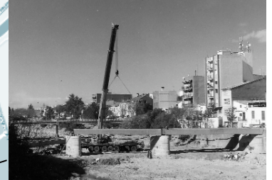
Obres de rehabilitació del Pont Vell
